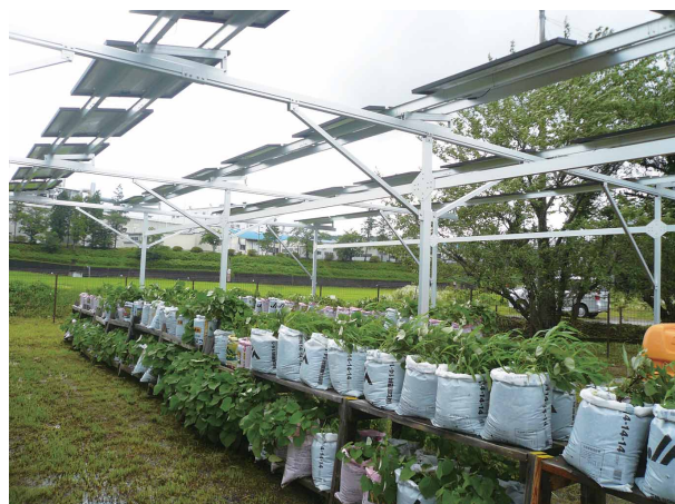
写真 サツマイモの空中栽培と営農型太陽光発電 (筆者撮影)
