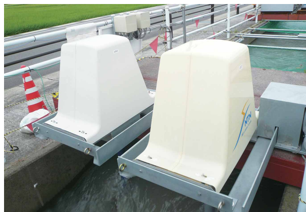
大井川土地改良区で農業用水路に設置した「NTNマイクロ水車」(筆者撮影)
